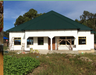
Revalidatiecentrum in aanbouw
