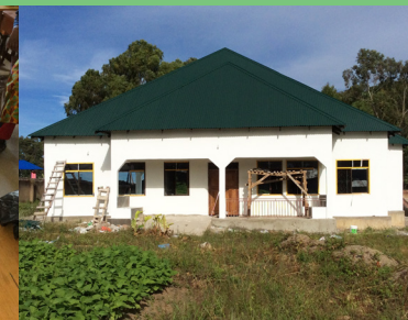
Revalidatiecentrum in aanbouw
